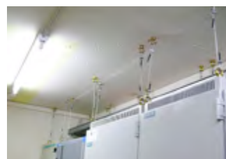
Schrankbefestigung
