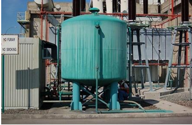
Abb. 2.17.5 > Aussteifung von aufgeständerten Tanks
