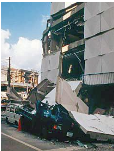
Herabgefallene Fassadenelemente
