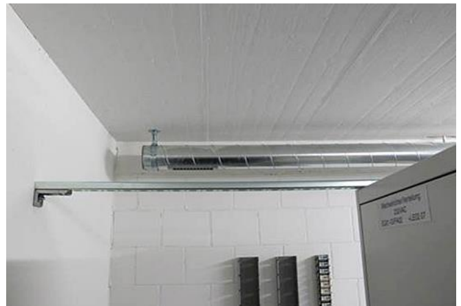
Abb. 2.13.5 > Verankerung von freistehenden Schrankeinheiten
