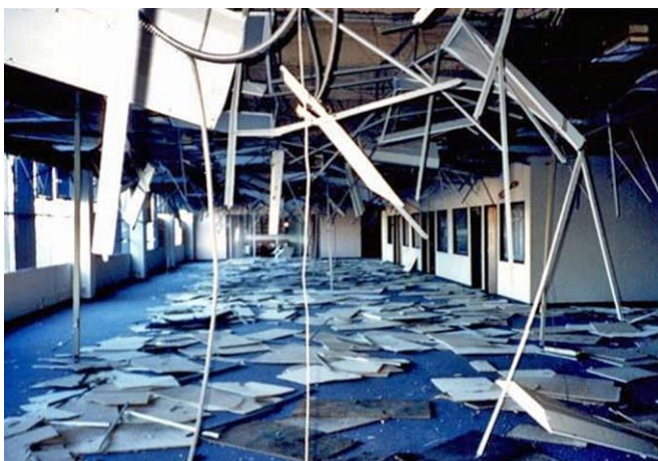
Abb. 2.2.1 bis 2.2.4 > Schäden an Deckenbekleidungen
