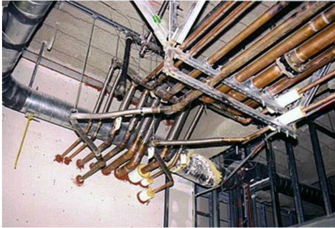
Abb. 2.18.10 > Flexible Verbindungen bei Wanddurchbrüchen, Aussteifung von Leitungstrassee
