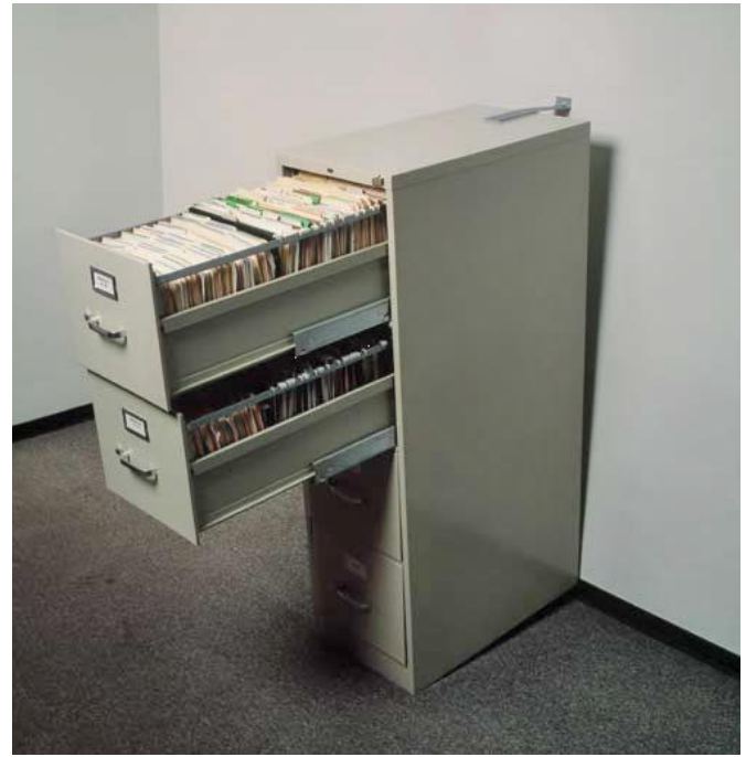
Abb. 2.21.5 > Befestigung Aktenschrank
