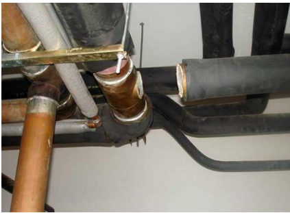
Gerissene Kupfer-Heisswasserleitung
