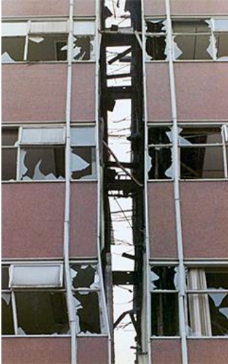
Abb. 2.8.1 > Herausgebrochene Fensterscheiben
