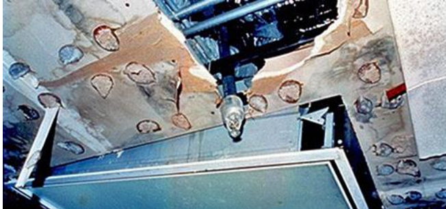
Abb. 2.12.1 und 2.12.2 > Beschädigter Sprinklerkopf
