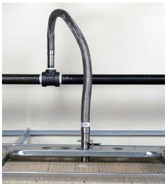
Abb. 2.12.3 > Flexible Abzweigung von Hauptleitung
