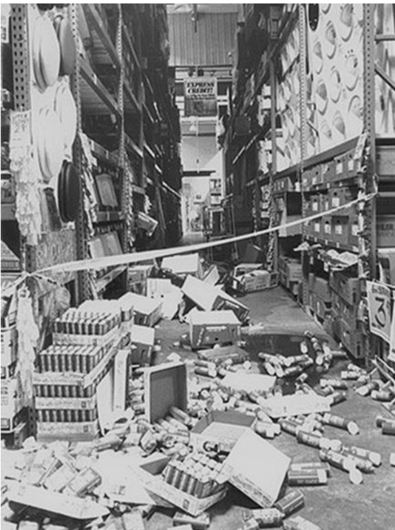
Abb. 2.23.4 und 2.23.5 > Beschädigtes Regal und herausgefallene Güter
