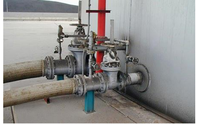
Abb. 2.17.6 > Flexibler Leitungsanschluss
