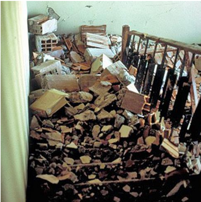
Abb. 2.7.3 &gt; Trümmerteile versperren den Treppenlauf
