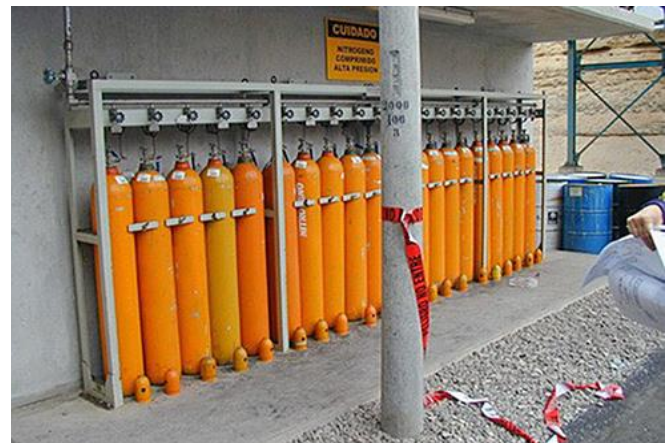
Abb. 2.17.8 > Befestigung von Zylinderflaschen
