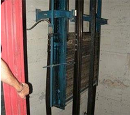
Abb. 2.19.1 > Führungsschiene durch Gegengewichte verbogen
