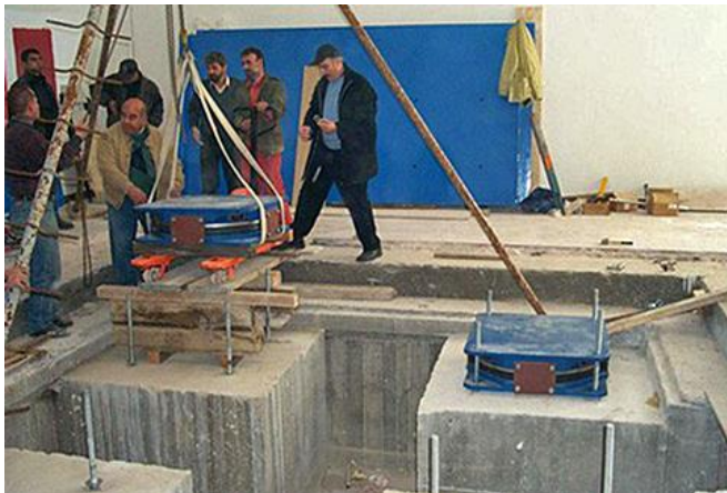
Abb. 2.25.6 und 2.25.7 > Schwungisoliertes Fundament für eine Skulptur
