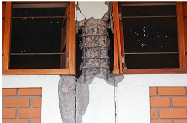
Abb. 2.4.2 > Schubbruch in kurzer Stütze bei Mauerwerksausfachung
