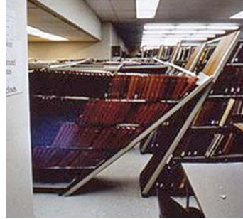
Abb. 2.22.1 und 2.22.2 &gt; Versagensmechanismus in der Ebene («in plane») bei Regalen
