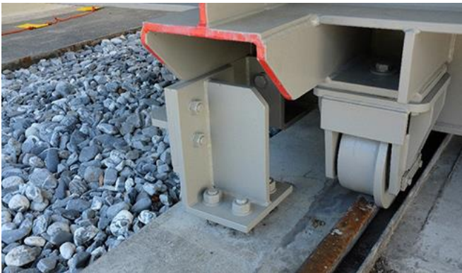
Abb. 2.14.3 &gt; Verankerung eines Transformators auf Fahrrollen
