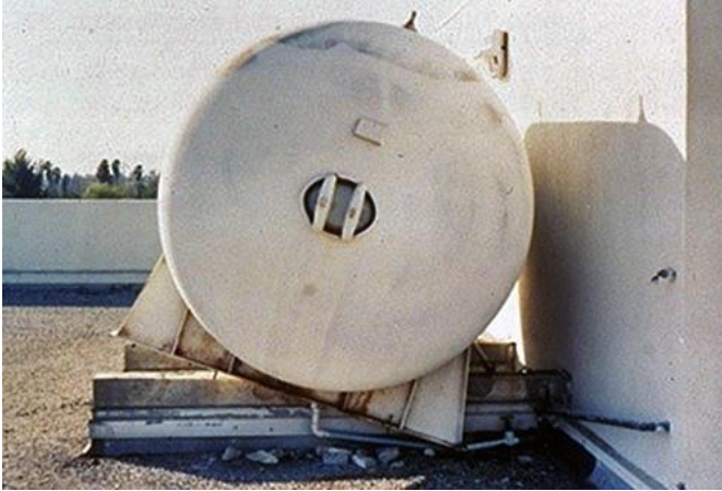
Abb. 2.17.1 und 2.17.2 &gt; Trägheitsversagen bei Tankwänden
