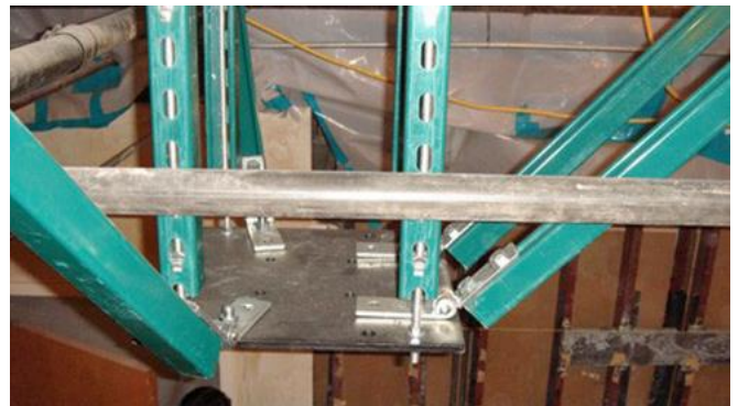
Abb. 2.15.4 &gt; Aussteifung schwerer Leuchtkörper
