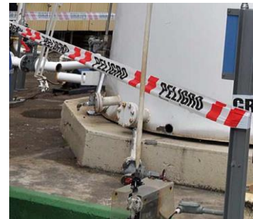
«Elefantenfuss» an ungenügend verankertem Benzintank
