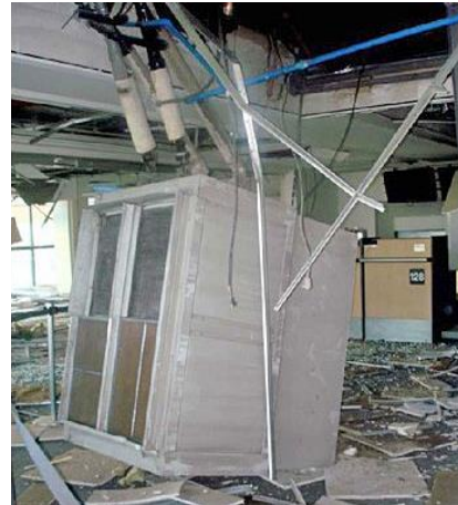
Abb. 2.16.2 &gt; Ungenügend ausgesteiftes Element
