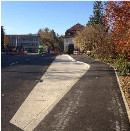
Abbildung 8: Hohe Haltekante mit „Nase“ (Bild: Kt. BL)
