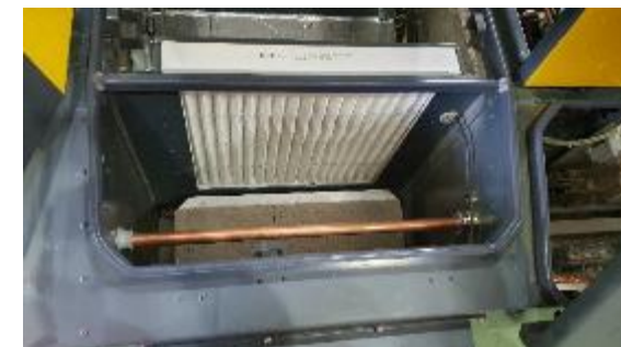
Rohrdurchführung ohne Lötverbindungen
