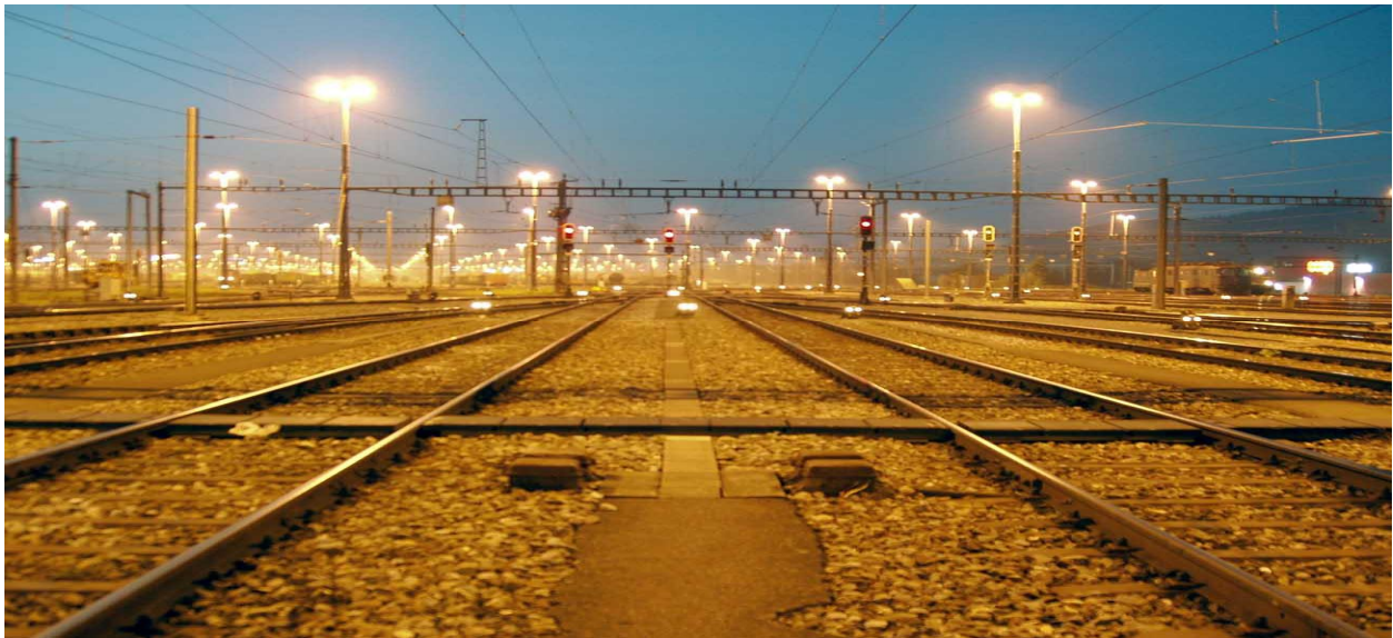
Gleisfeldbeleuchtung am Rangierbahnhof Limmattal mit Natriumdampfleuchten (bis 2014).
