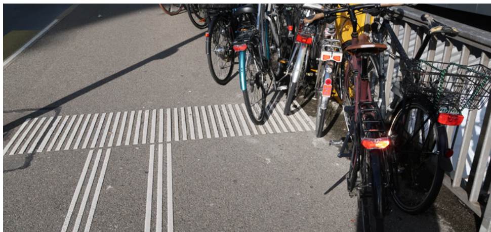
Les éléments structurels permettant de s'orienter et les marquages tactilo-visuels doivent rester libres d'obstacles
