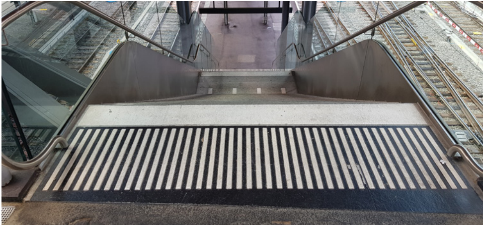
Descente/montée d'escalier avec marquages de début et palier intermédiaire (dents de pelle)
