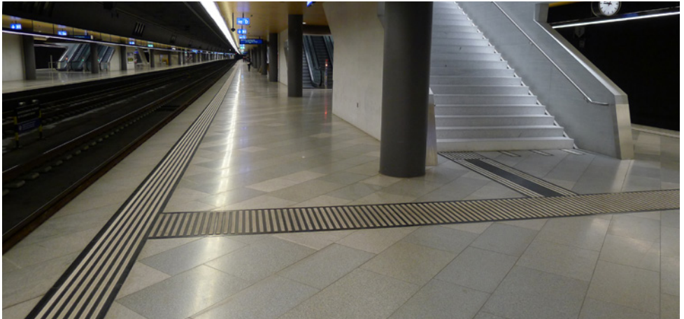
Quai de gare avec lignes de sécurité et de repérage de la sortie du quai
