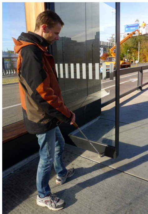
Paroi vitrée marquée et ne laissant pas la canne longue passer dessous
