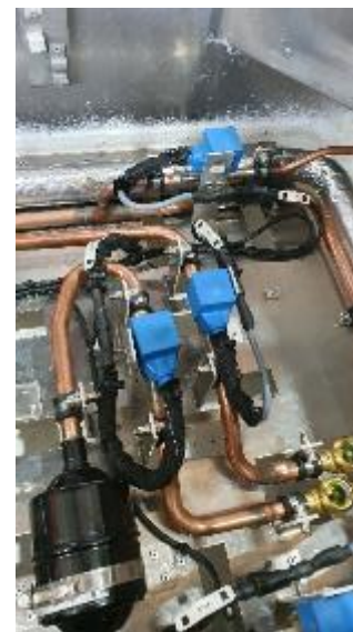
Vannes Mg. / Filtres déshydrateurs
