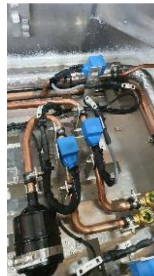
Vannes Mg. / Filtres déshydrateurs
