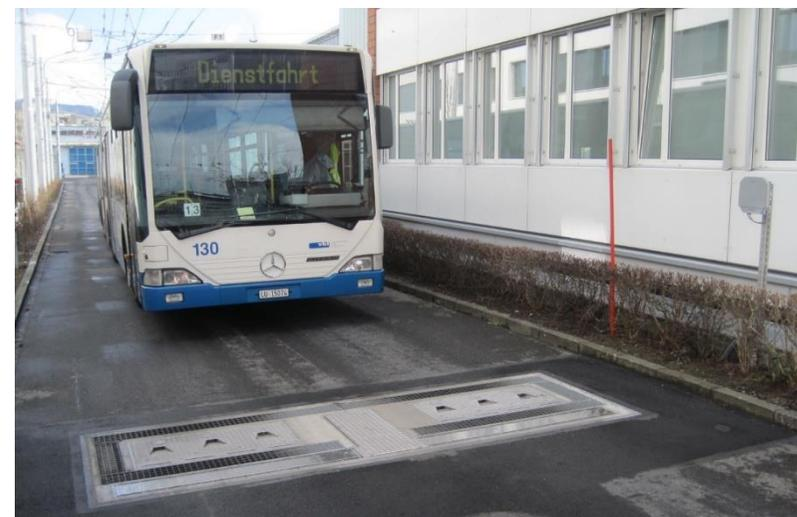
*Reifendruck- und Profilmessanlage in der Ausfahrt vom vbl-Depot*
