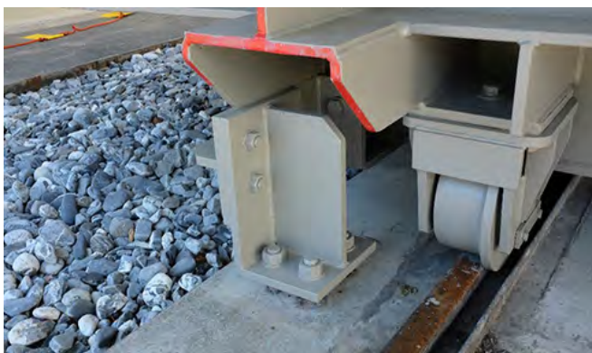
Fig. 2.14.3 &gt; Fixation d'un transformateur monté sur roues
