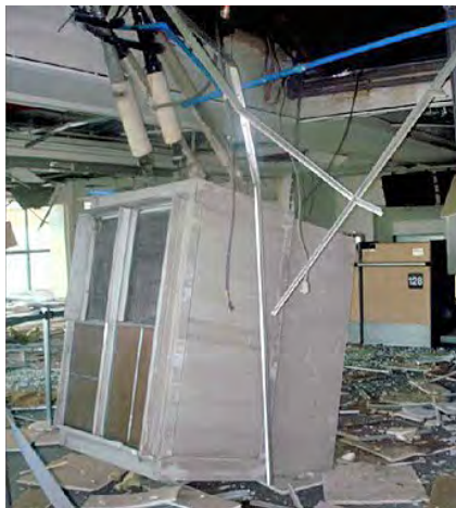
Fig. 2.16.2 &gt; Élément insuffisamment contreventé
