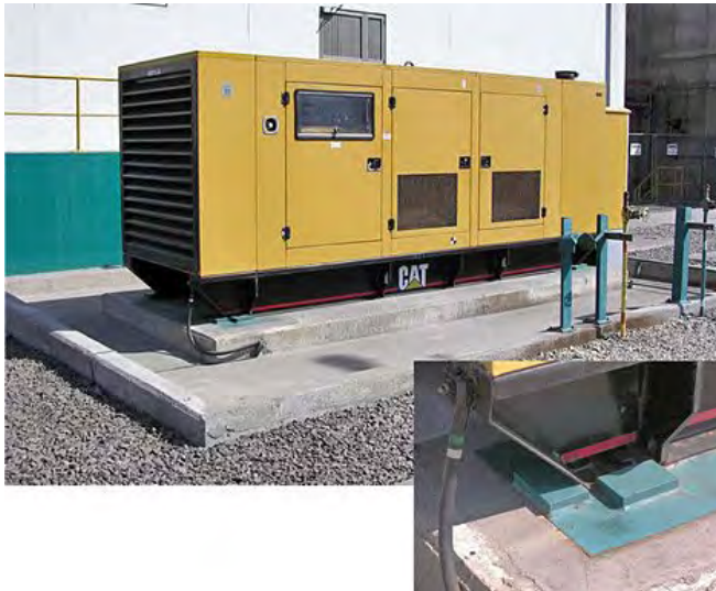
Fig. 2.16.7 > Butée horizontale bloquant un générateur
