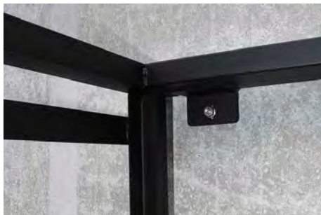
Fig. 2.3.7 > Fixation du châssis de base au mur
