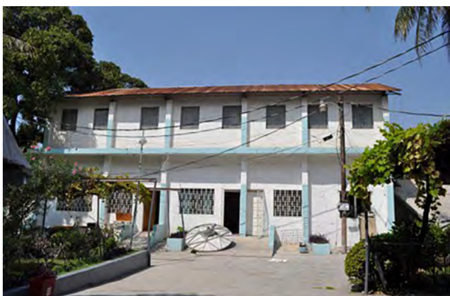
Fig. 2.21.3 &gt; Antenne parabolique tombée à terre
