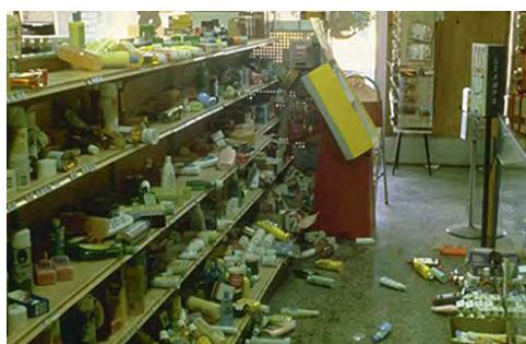
Fig. 2.22.7, 2.21.8 et 2.22.9 &gt; Dégâts malgré des étagères intactes
