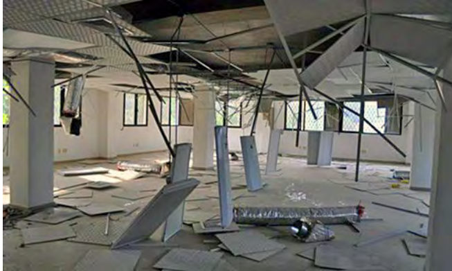
Fig. 2.15.1 et 2.15.2 > Chute d'éléments d'éclairage
