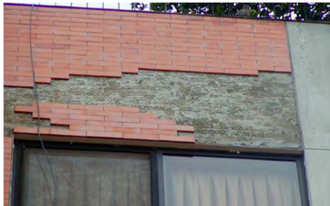
Fig. 2.5.2 > Décollement d'éléments
