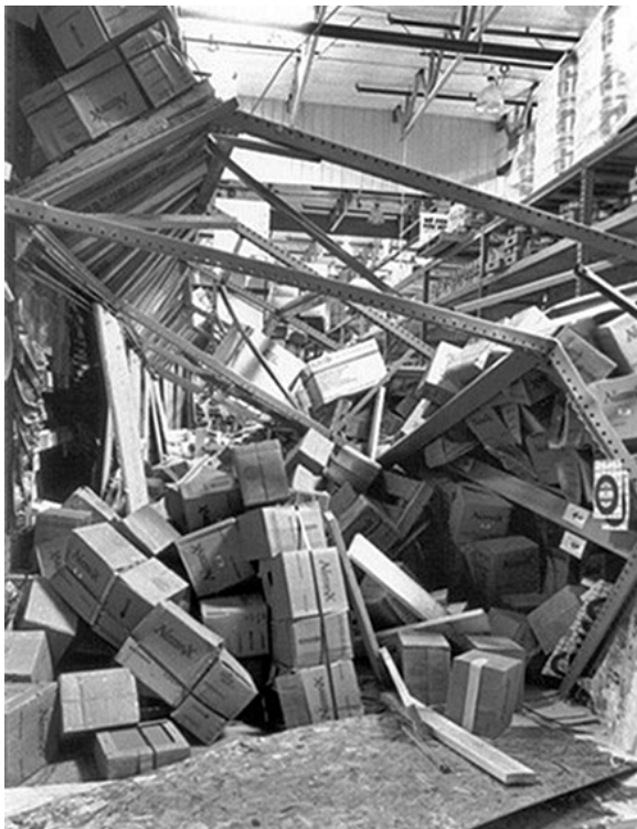
Fig. 2.23.1, 2.23.2 et 2.23.3 &gt; Effondrement d'un entrepôt d'étagères
