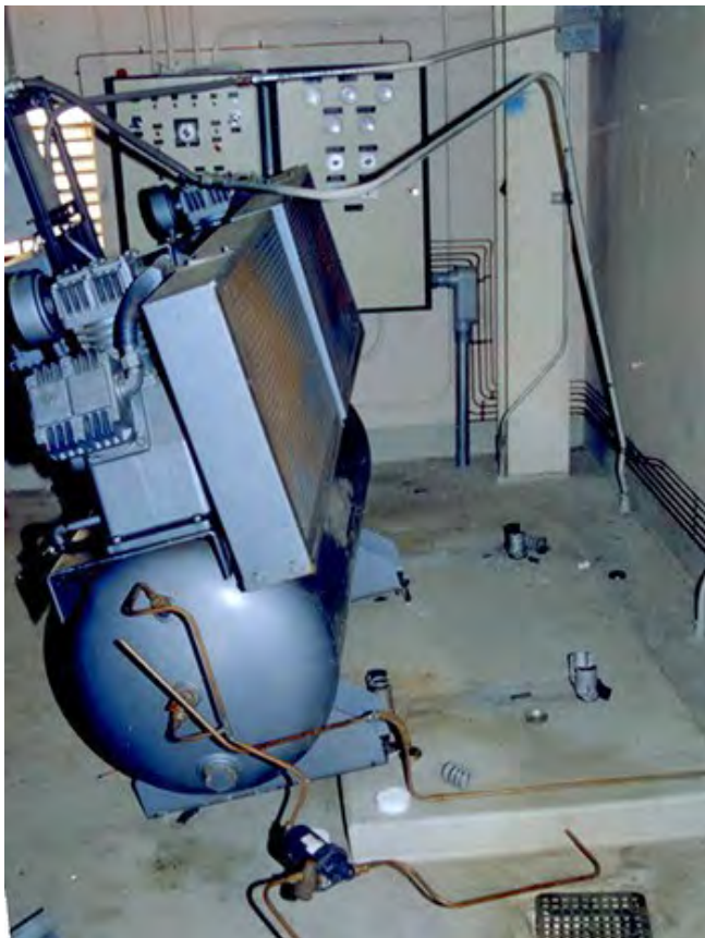
Fig. 2.20.1 > Ruine de l'appui d'une installation isolée contre les vibrations
