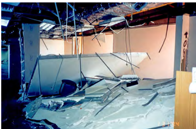
Fig. 2.4.3 et 2.4.4 > Dégâts subis par des parois en construction légère
