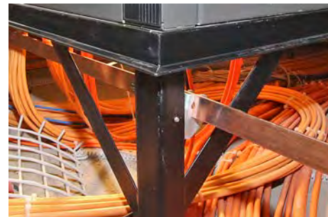
Fig. 2.3.8 > Stabilisation horizontale par barres diagonales
