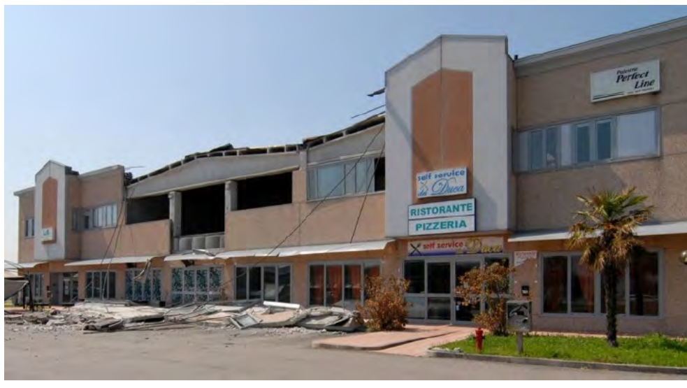
Fig. 1.7 > Façade tombée sur la terrasse d'une pizzeria, Emilia-Romagna, 2012
