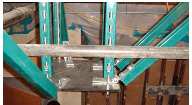
Fig. 2.15.4 > Contreventement de luminaires lourds
