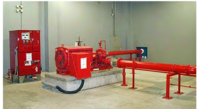
Fig. 2.12.4 > Fixation de la pompe et de l'unité de commande, raccords flexibles et jeu ménagé au passage à travers un mur
