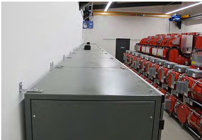
Fig. 2.13.6 et 2.13.7 > Sécurisation de coffrets ou d'armoires contre une paroi
