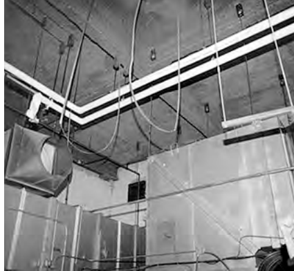
Fig. 2.18.2 &gt; Chute d'une conduite
