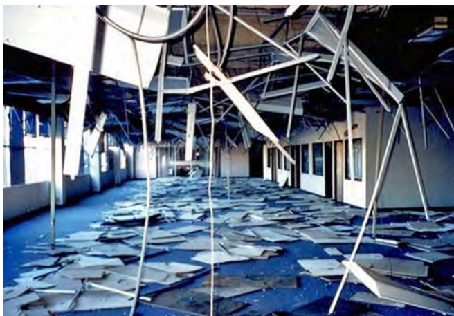
Fig. 2.2.1 bis 2.2.4 > Dégâts subis par des faux-plafonds suspendus
