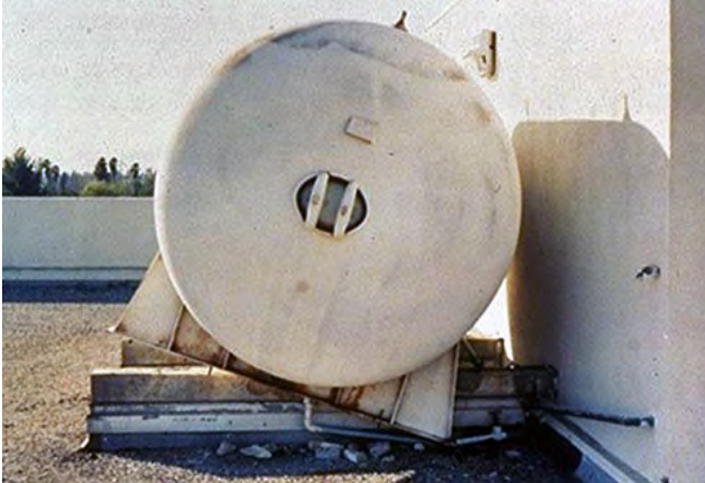
Fig. 2.17.1 et 2.17.2 &gt; Effet des forces d'inertie sur des citernes
