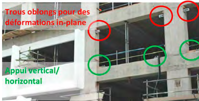
Fig. 2.5.5 > Consolidation d'éléments de façade par des trous oblongs
