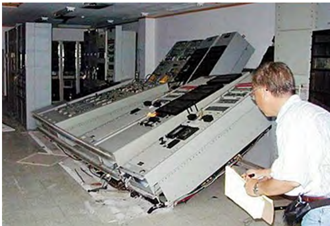
Fig. 2.13.1 et 2.13.2 &gt; Armoires de commande renversés
