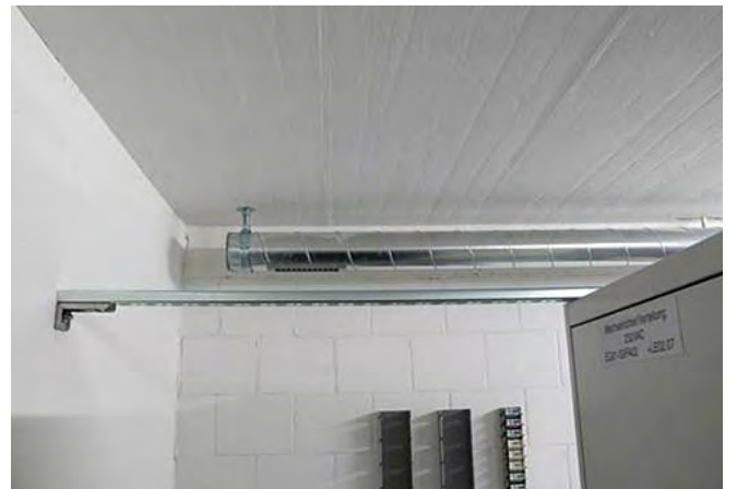
Fig. 2.13.5 > Fixation d'armoires/boîtiers autonomes sur pieds
