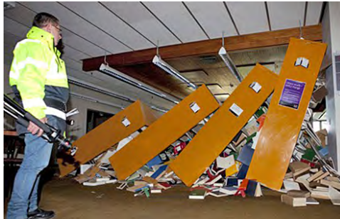
Fig. 2.22.5 et 2.22.6 &gt; Renversement de plusieurs rangées d'étagères par effet domino
