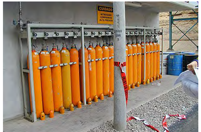
Fig. 2.17.8 > Fixation de bonbonnes
