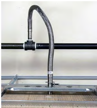
Fig. 2.12.3 > Raccord flexible à une conduite principale
