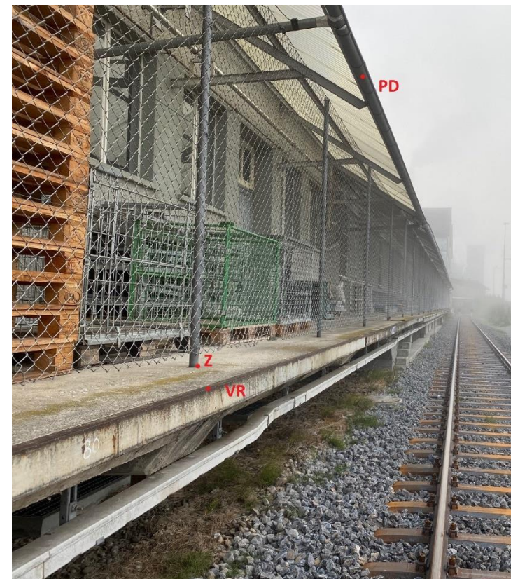
Clôture sur un quai de chargement
